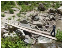
Der ursprüngliche Überweg
